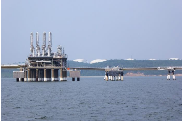
The Cove Point LNG (Liquefied Natural Gas) Terminal
