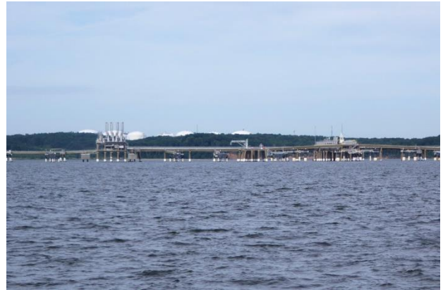
The Cove Point LNG Terminal
